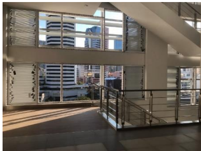
ภาพที่ 7 ราวกันตกที่สร้างเสร็จเรียบร้อยแล้ว
